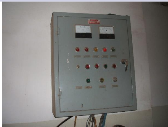
辐照装置的控制柜，只有风机控制按钮
