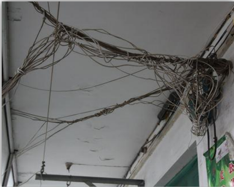
私自乱接电线，强弱电线混杂
